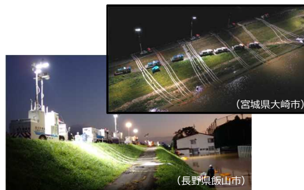
排水ポンプ車による24時間体制の緊急排水状況 (宮城県大崎市)
