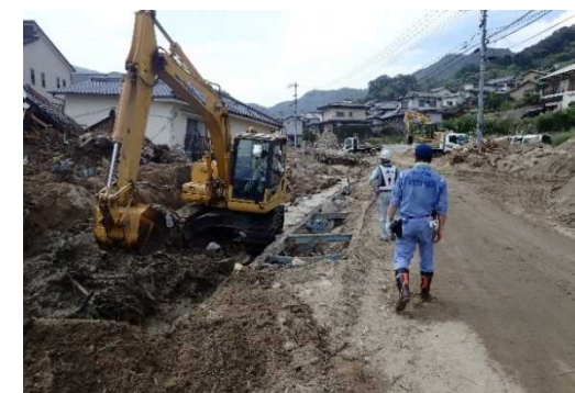
河道閉塞箇所における土砂等の撤去作業 (広島県坂町)
