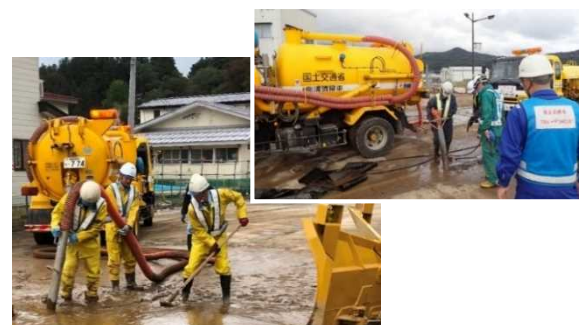
協力企業と一体となった堆積土砂の撤去 (長野県長野市)
