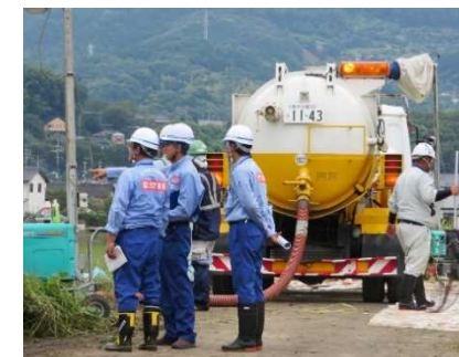
流出した油を回収するため 側溝清掃車を現地に派遣 (佐賀県大町町)
