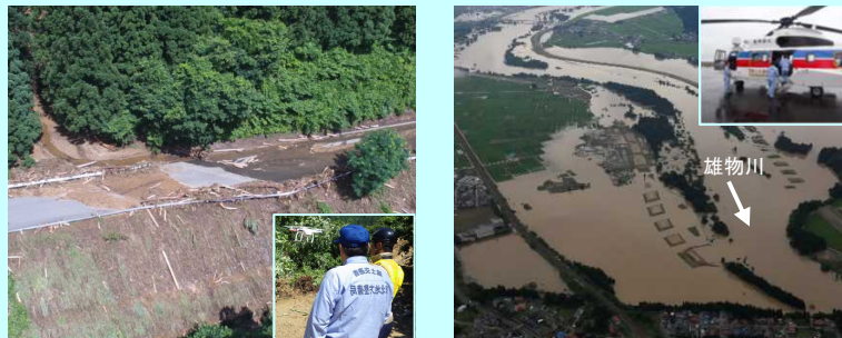
ドローンによる被害状況調査(横手市) ヘリによる被害状況調査(大仙市)
