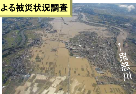
【H27.9 関東・東北豪雨】 (茨城県常総市)
