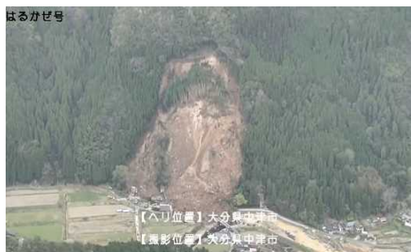
防災ヘリによる被災状況調査
