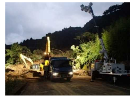
道路啓開夜間作業を照明車が支援 (宮崎県串間市 国道448号)
