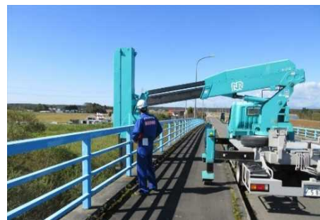
町道橋梁の緊急点検を支援 (北海道勇払郡厚真町)
