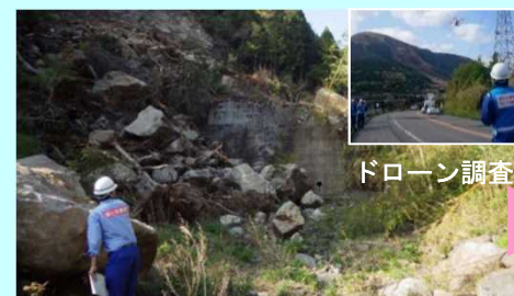
土石流危険溪流の点検
