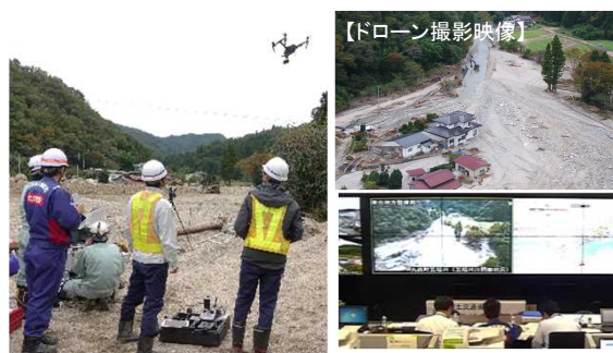
ドローンを活用した被災状況調査と衛星回線を用いたリアルタイム映像配信 (宮城県丸森町)
