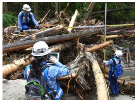
被災状況調査班によるタブレットを 活用した流量調査 (佐賀県佐賀市)
